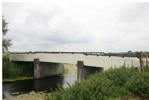
De brug Tjaerderdyk is ook een bouwwerk dat een gemeentelijk monument is
